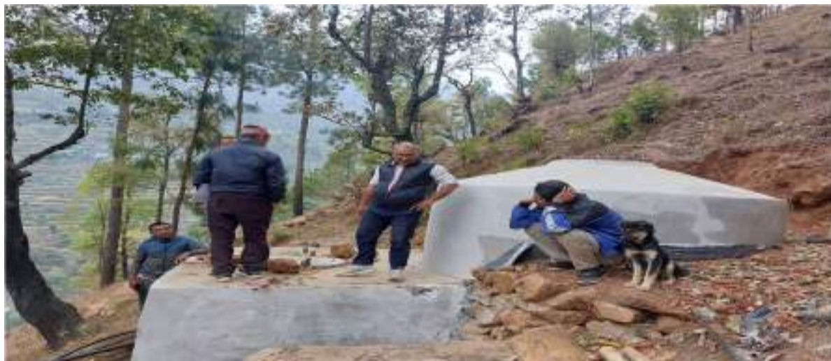
निर्माण गरिएको खानेपानी ट्याङ्की झिमरुक ?
